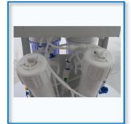
Setzen Sie den Deckel wieder zurück auf das Gehäuse und schrauben Sie es im Uhrzeigersinn mit Hilfe des Membrangehäuse-Schlüssels wieder zu.
